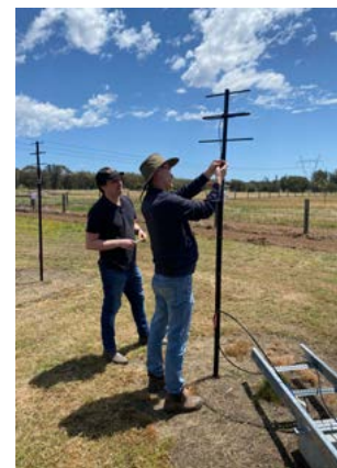
Figure 3 Installing ERA antennas.
